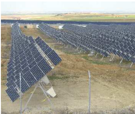
2,1 MW sobre seguidores em Peleas de Abajo (Zamora)
