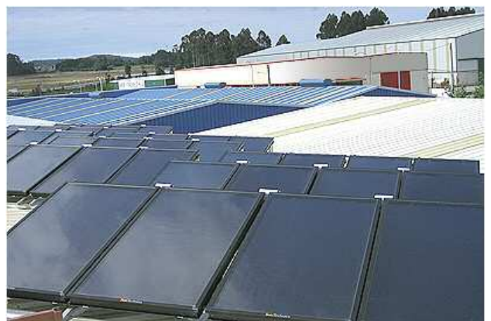
Instalação de 96m 2 de superfície de captação para climatização solar com máquinas de absorção em Narón (A Corunha)
