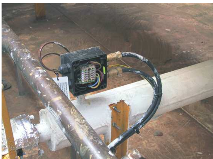
Caixa conexão para o controlo do tracejado
